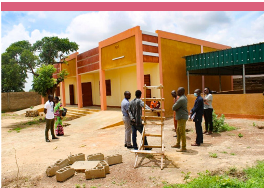
Vue extérieure du centre
